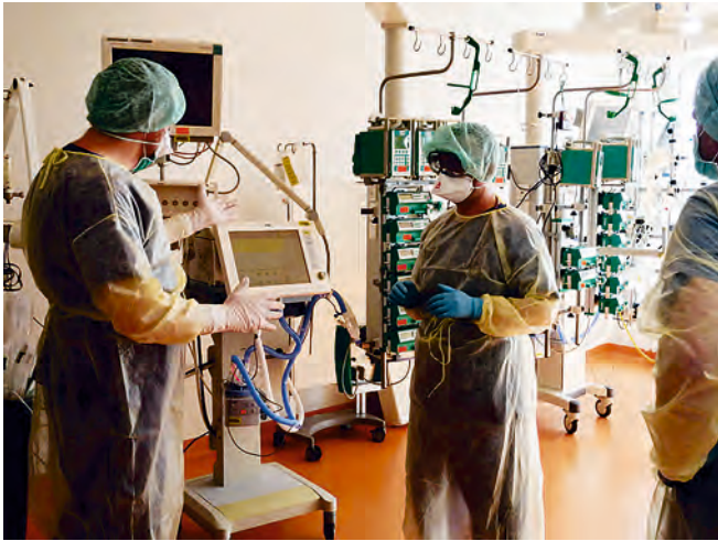
Vorbereitung der Patientenzimmer auf Intensiv
